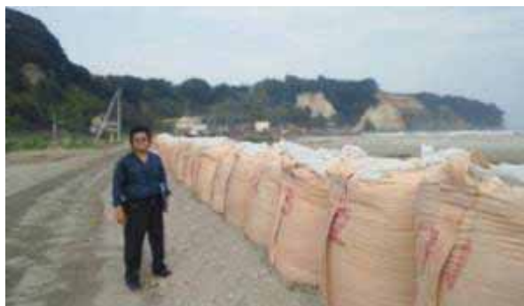
東日本大震災；海岸護岸が全壊して仮復旧工施工。 福島県小名浜 2011/8/8
